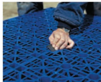
4. A vízszintes és függőleges csatlakozó klipszekkel egymáshoz rögzítjük a blokkokat.
