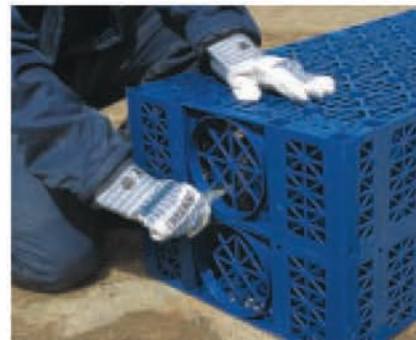
2. A bekötési pontoknál a perforált csatlakozási pontot kivágjuk.
