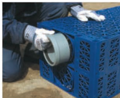
3. Elhelyezzük a csatlakozó csomókat a megfelelő blokkokra.
