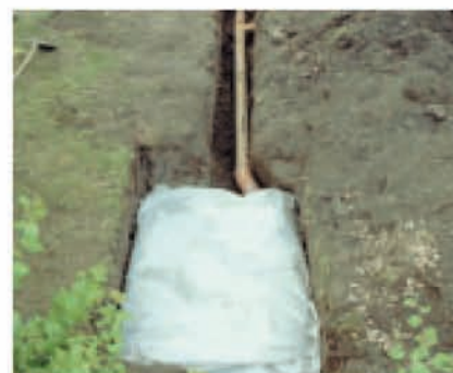
6. A teljes rendszert min. 15 cm-es átlapolással körbeburkoljuk geotextiliával.
