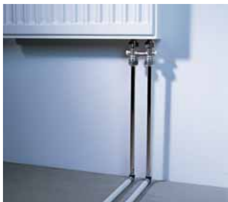
Подсоединение с помощью подводки для радиаторов
