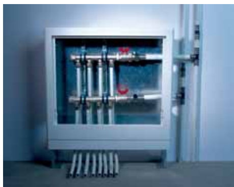
Подводка трубы к коллекторам
