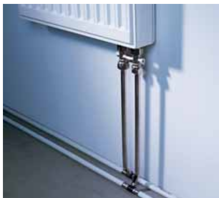
Подсоединение с помощью подводки для радиаторов
