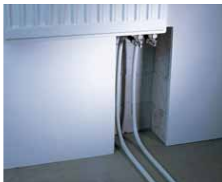
Непосредственное подключение труб к радиатору
