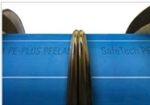
Efter svejsningen ses en tydelig forskel ved svejseområdet. Dette skyldes de to rørmaterialers forskellige egenskaber.
